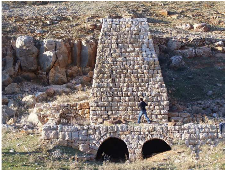
شکل ۳- الف: آسیاب غلات با دو سرناره در راشیا، لبنان.
